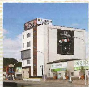
フジバンビ本社ビル
